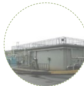
生活污水处理设施
